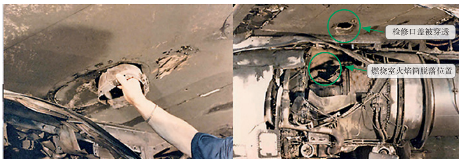
KT28M 受损的油箱检修口盖
