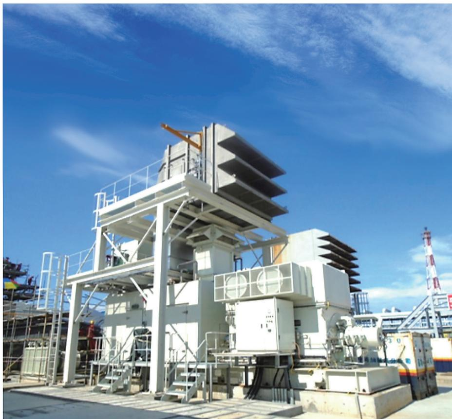
中海油海南东方终端 AGT-7 燃气轮机发电机组
